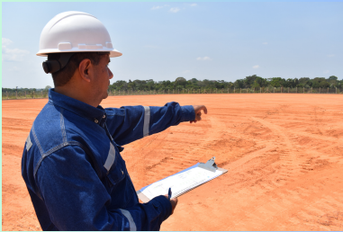
Inspección a la construcción de la nueva subestación Riberalta
